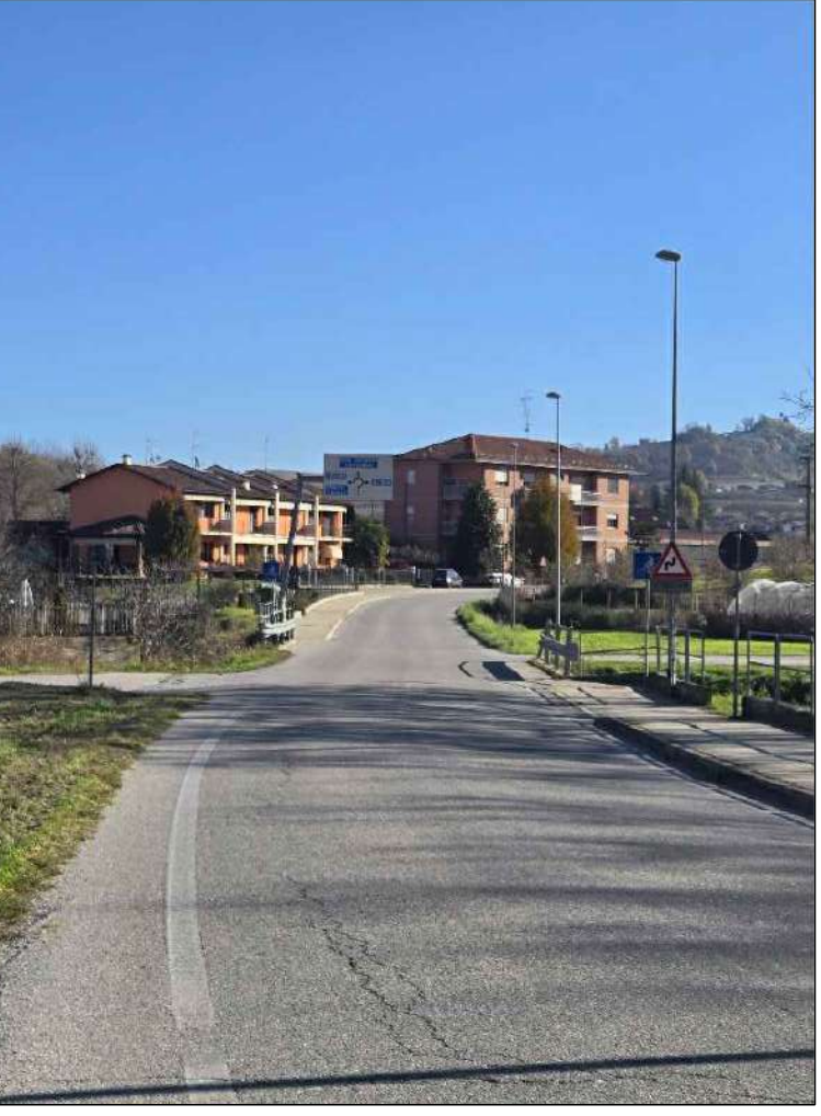
FOTOGRAFIA N.5 ATTRAVERSAMENTO NON A NORMA
