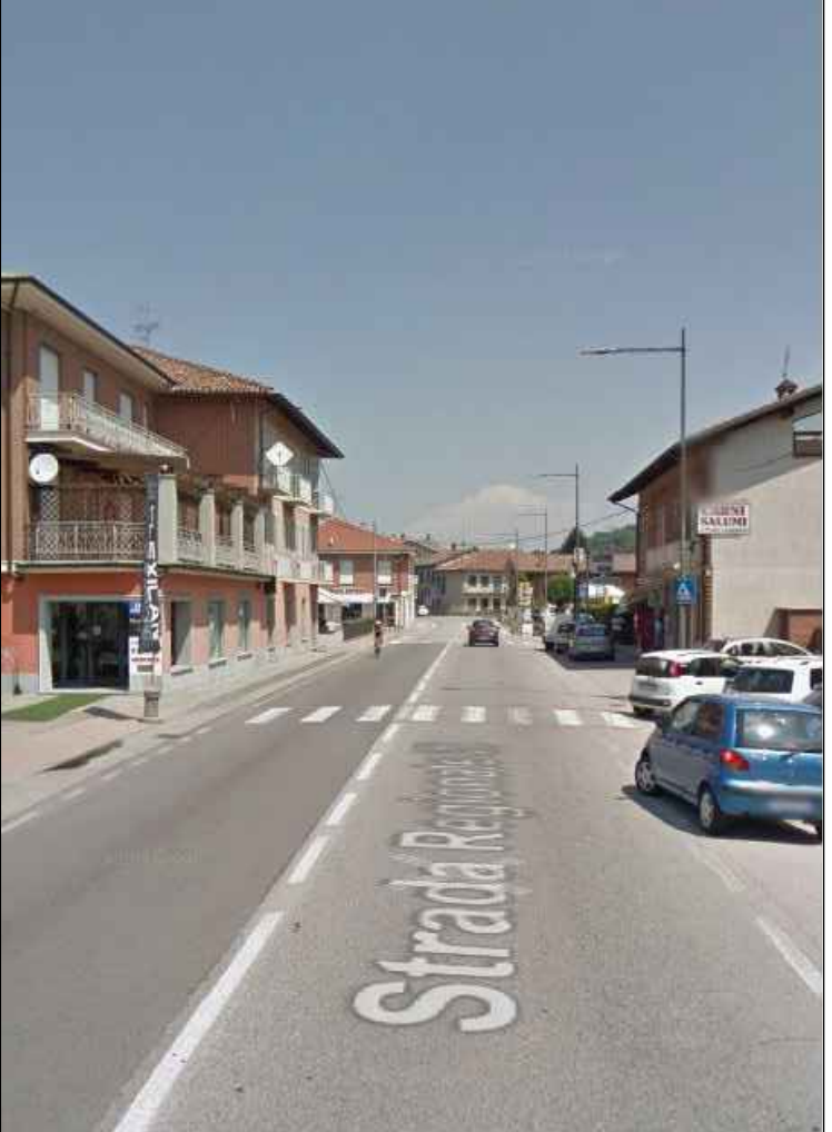
FOTOGRAFIA N.11 ATTRAVERSAMENTO NON A NORMA
