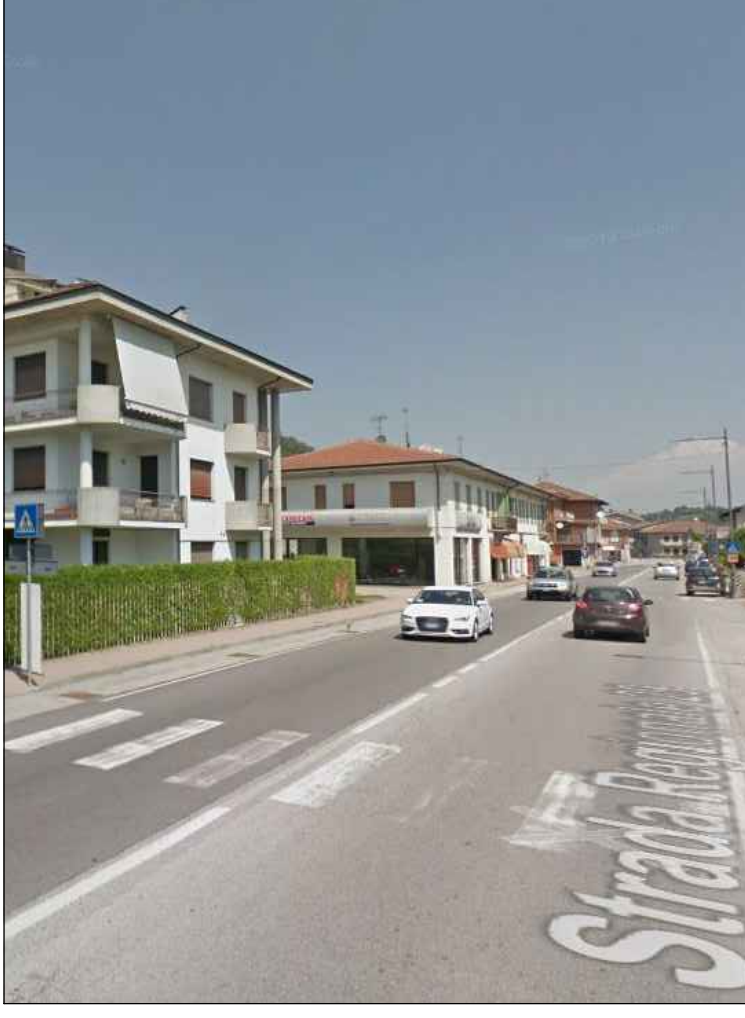
FOTOGRAFIA N.10 ATTRAVERSAMENTO NON A NORMA
