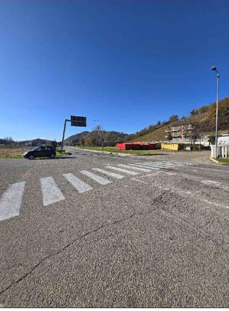
FOTOGRAFIA N.6 ATTRAVERSAMENTO NON A NORMA
