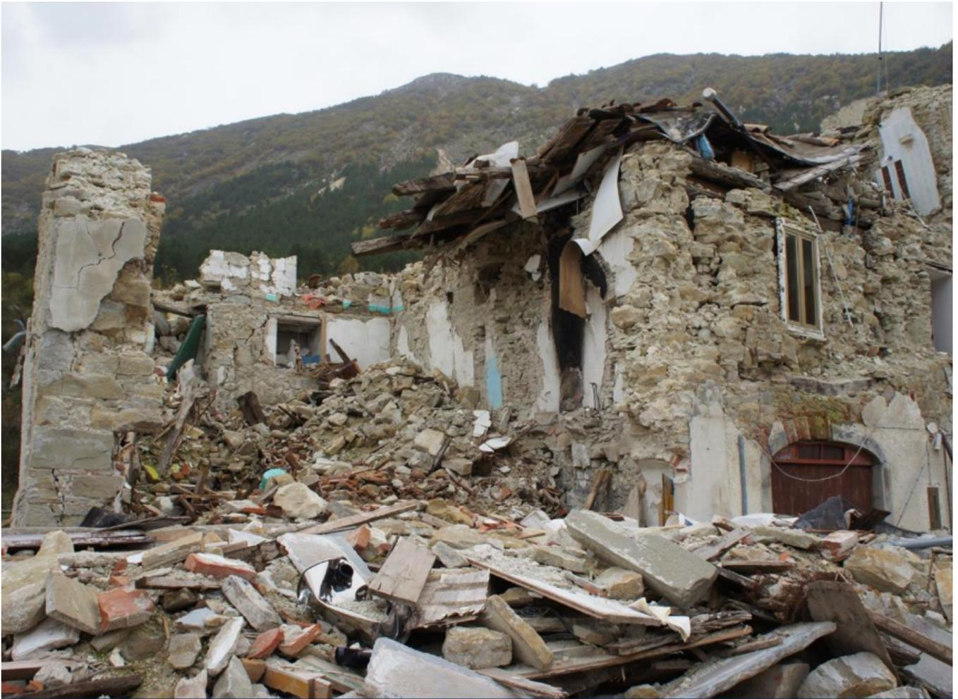
1- Collasso per disaggregazione della muratura
