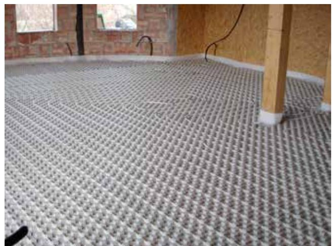
Sistema di riscaldamento a pannelli radianti
