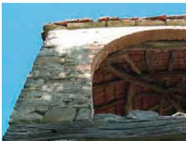
legno utilizzate come architravi. In questo caso, generalmente, gli architravi in legno delle grandi aperture corrispondono alla struttura del tetto e sono sorrette da pilastri o porzioni di muratura in elevazione. In corrispondenza delle aperture ad arco talvolta sono presenti elementi trasversali in legno con funzione di catena, posti in corrispondenza del piano d'imposta dell'arco, specialmente nei loggiati.
