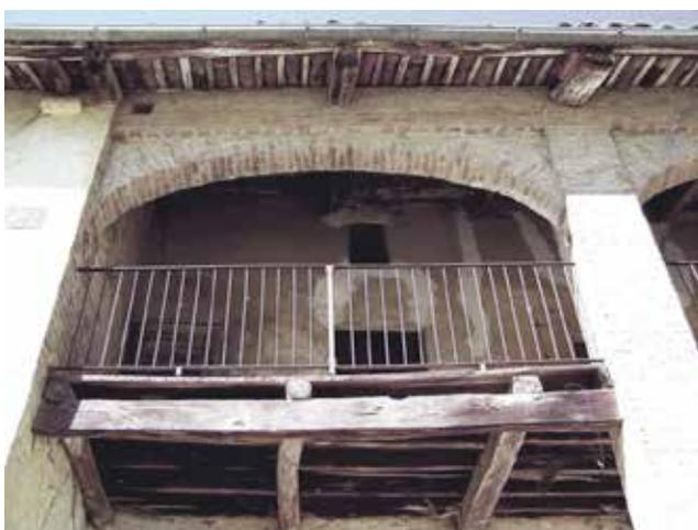
In questo modo nascondevano le testate delle mensole proteggendole da infiltrazioni di acqua meteorica, e rifinivano il perimetro del ballatoio.
