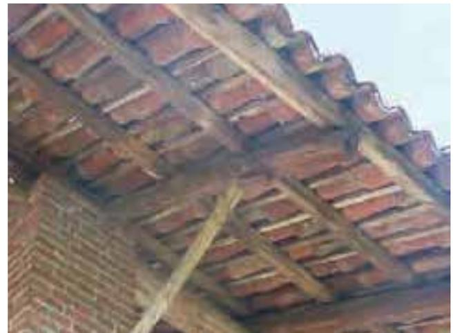
strutture lignee di sostegno variano in relazione al tipo di manto impiegato e alla localizzazione dell'edificio.
