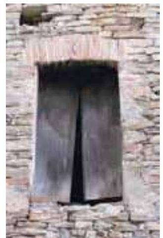
lo spessore della muratura, a voltini e archi di scarico che hanno la funzione di deviare il carico della muratura soprastante le aperture sulle spalle dell'apertura stessa.
