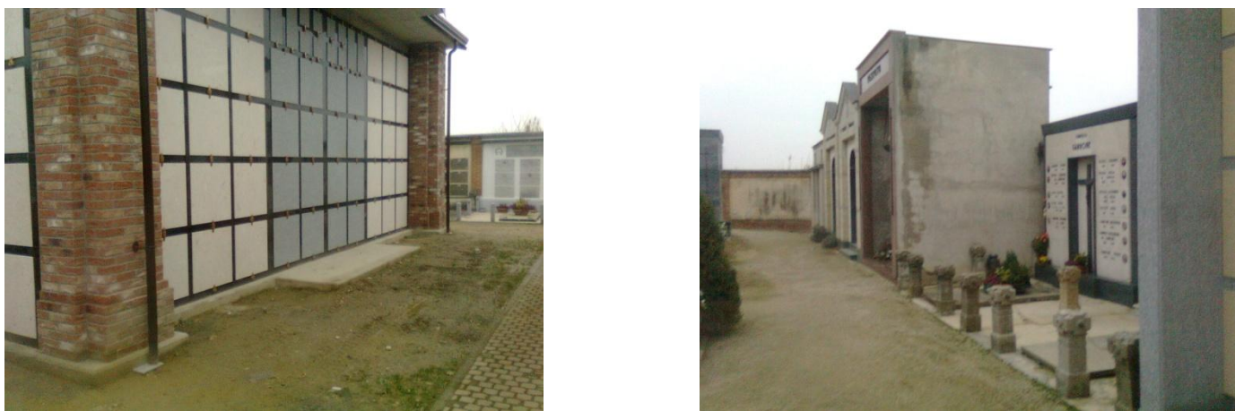
Fig. C20-C21. Viali pedonali: lato Nord e vialetti laterali
