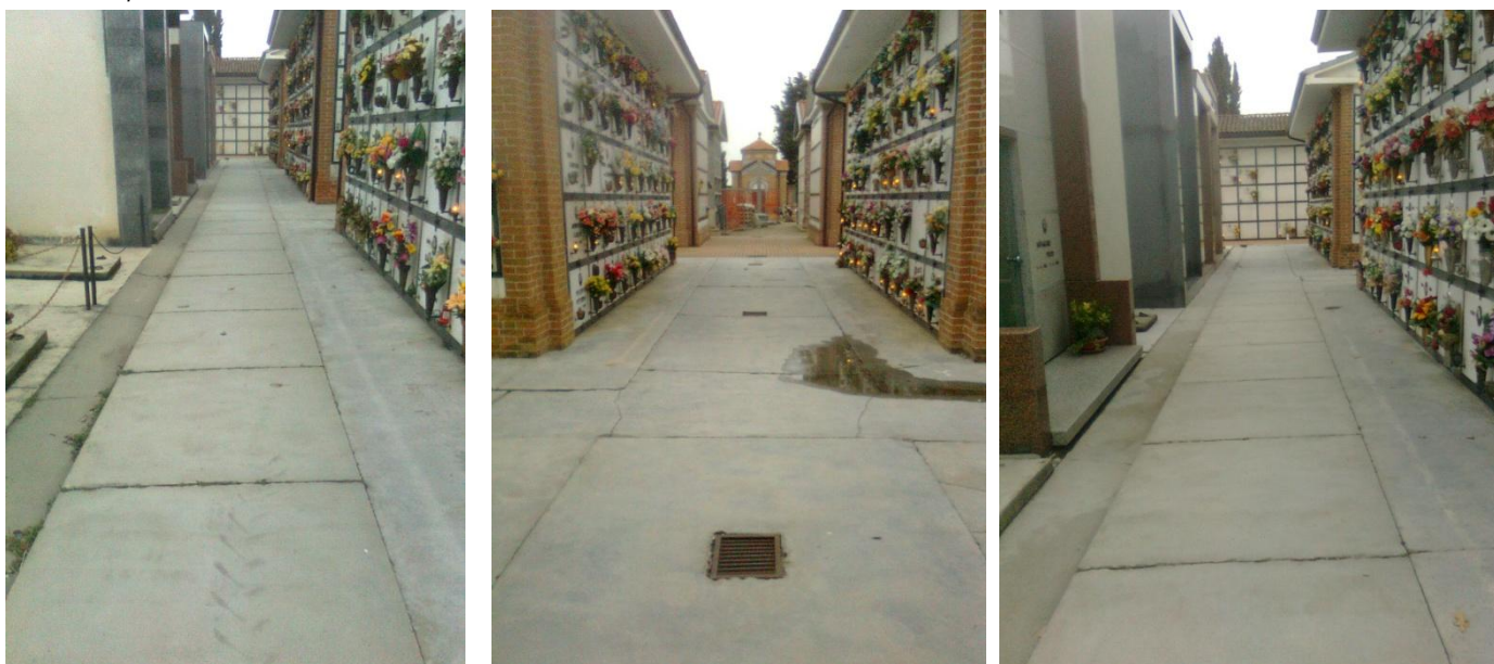
Fig. C17-C18-C19. Viali pedonali: lato Ovest, asse centrale, lato Est con i dettagli delle pavimentazioni e delle griglie di raccolta acqua
